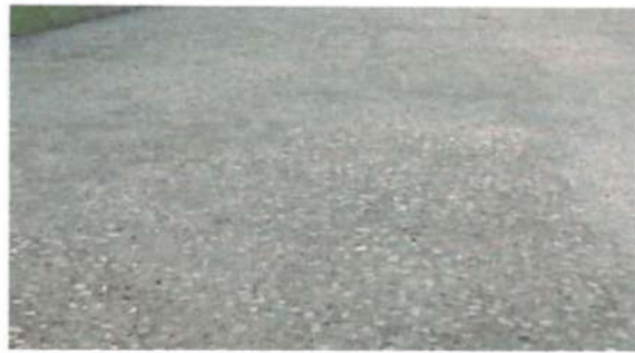
Foto 2: Sustitución de losa de concreto en el patio de la escuela por losa de concreto
