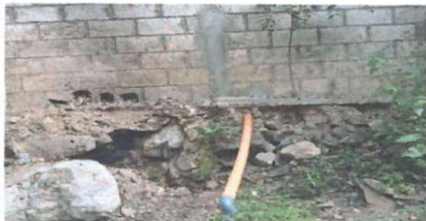
Foto 1: Reforzamiento a muro perimetral a un costado de la quebrada
