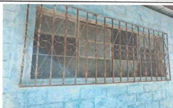
Foto 2: Mantenimiento de balcones oxidados en aulas, lijado y pintura.
