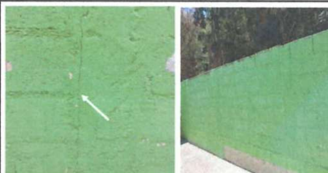
Foto 4: Refuerzo del muro perimetral del lado de la quebrada con arena y cemento.
