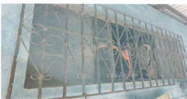
Foto 3: Sustitución de ventanas de metal y vidrios por ventanas de PVC
