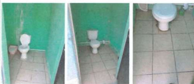
Foto 5: Sustitución de piso cerámico deteriorado por piso cerámico en baños.
