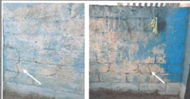
Foto 3: Refuerzp de muro que divide la escuela con el salón comunal
